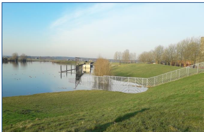
Locatie nieuw gemaal nabij hekwerk.
