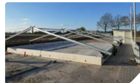
Staalconstructie van de mobiele overkapping is geplaatst
