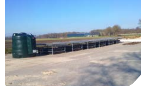
De Phytobac® in aanbouw; de opvangtank en 6 containers zijn geplaatst
